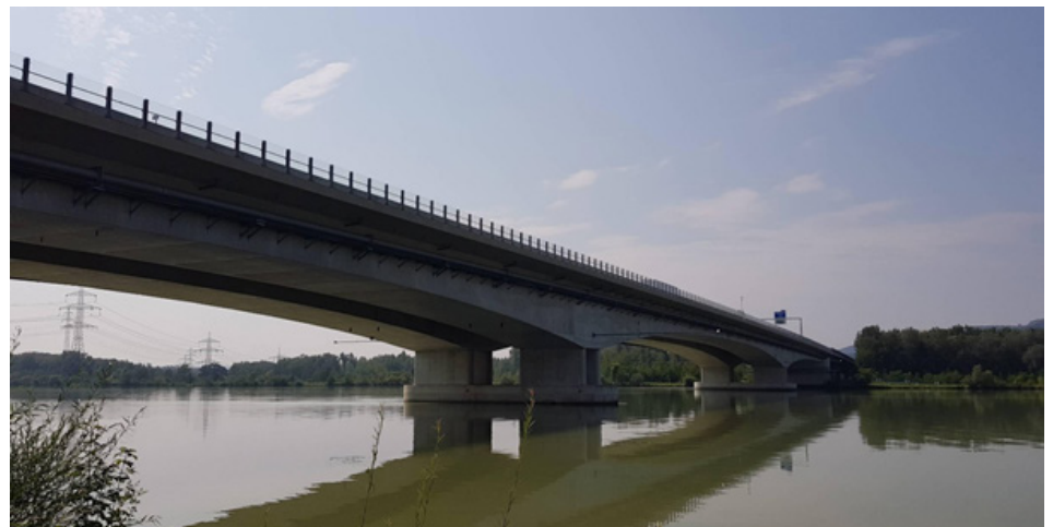
Ansicht der Donaubrücke Traismauer am Messtag
