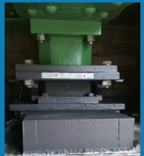
Beispiel einer durchgeführten Lagerinstandsetzung
