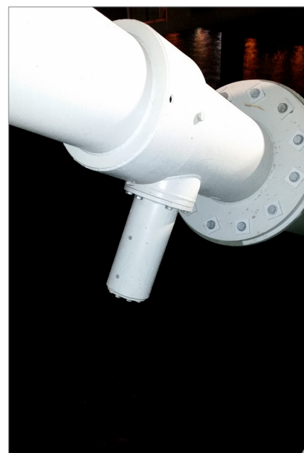
Aktivierter Dämpfer im Verankerungsbereich
