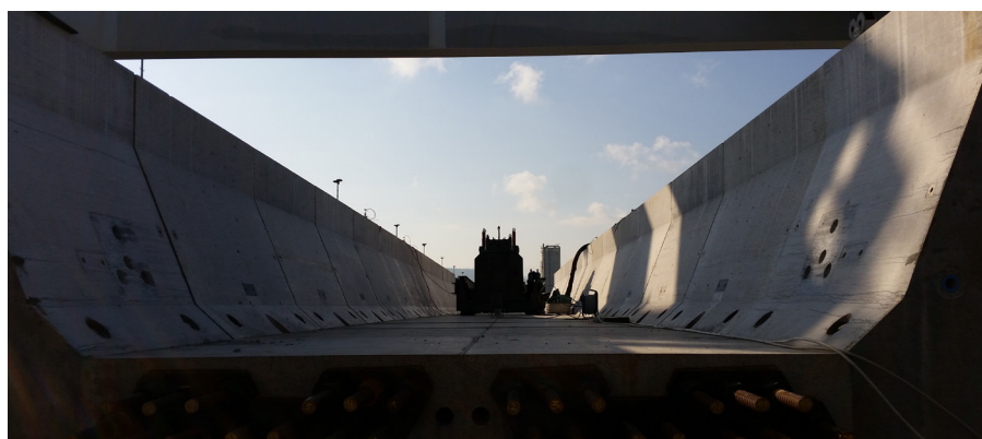
Ansicht des Querschnitts der UHPC-Hilfsbrücke inkl. Schwingungsanreger
