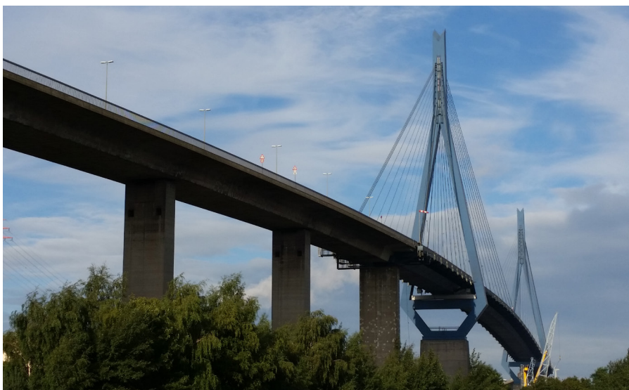
Ansicht der Köhlbrandbrücke
